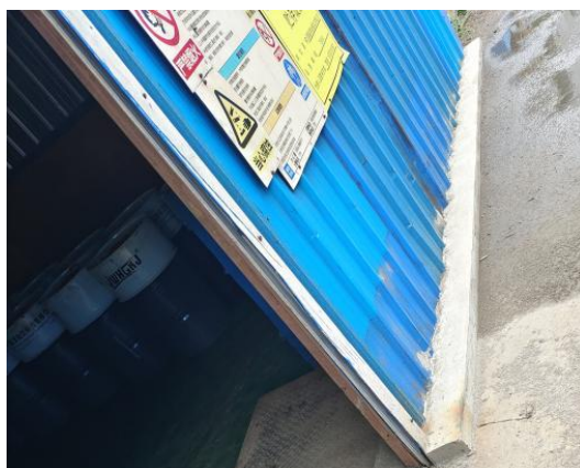
整改后：能一定程度上阻拦雨水进入危废间
