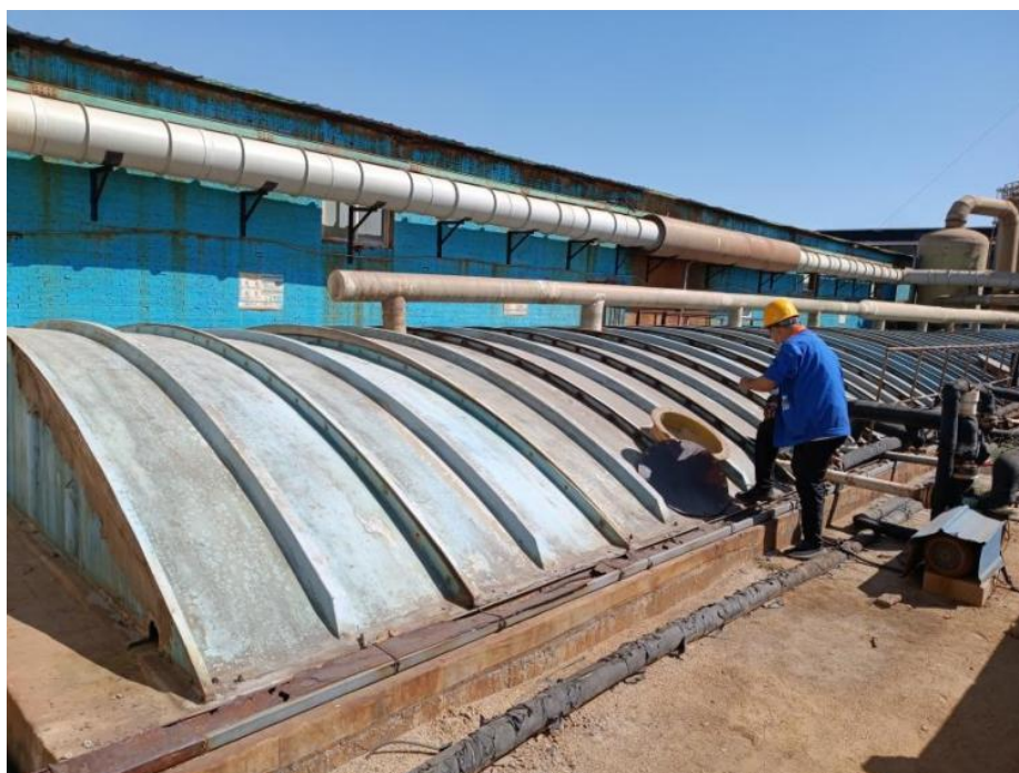
图 4.2-6 废酸池池体类储存设施照片
